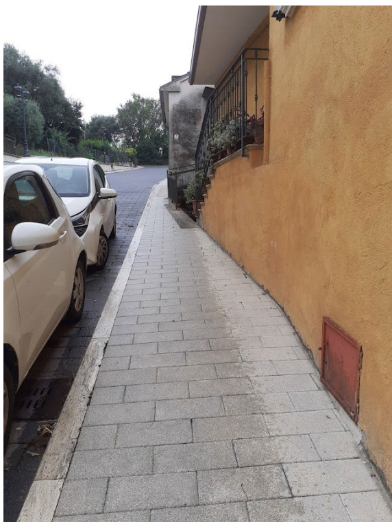
Fot. 3 Marciapiede su Via A.Moro
