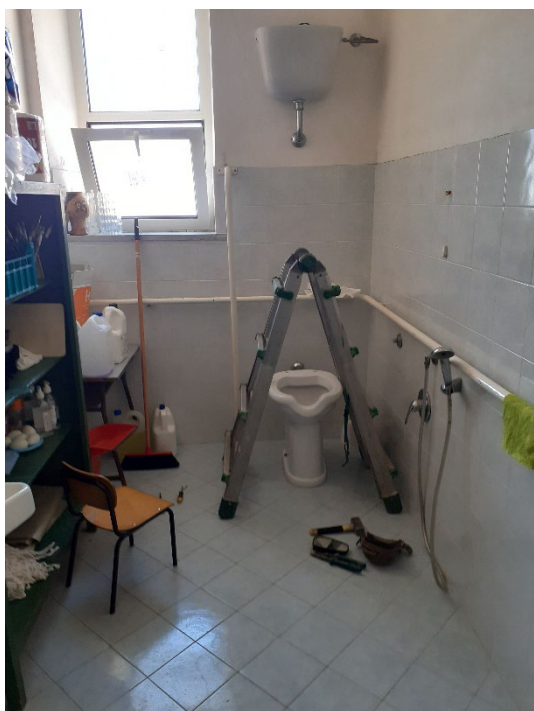
Fot. 7 interno servizio igienico
