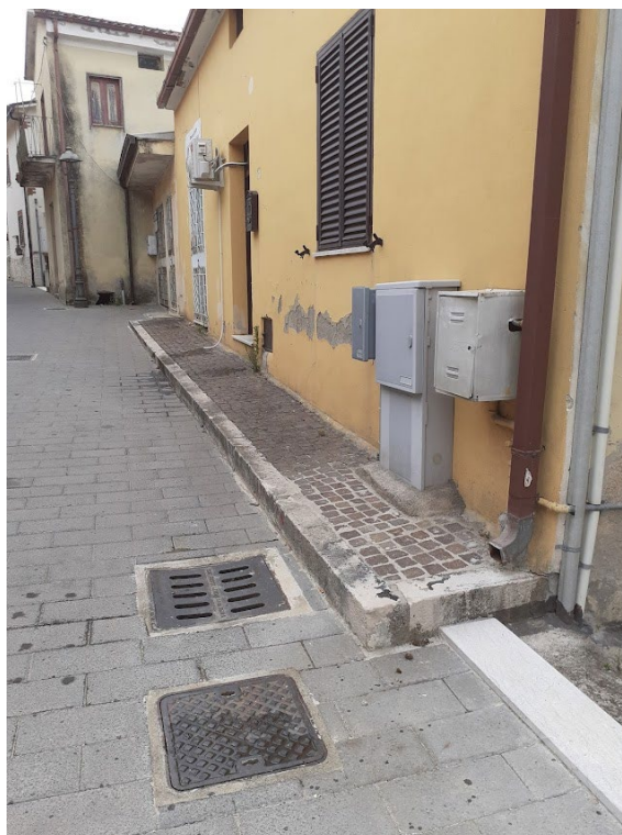
Fot. 5 Via Roma – tratti con inserimento di marciapiede
