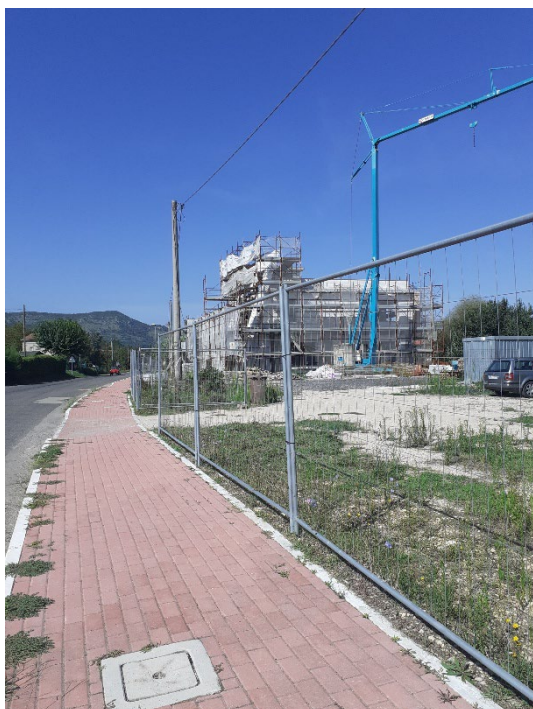
Fot. 3 con il cantiere dell'asilo nido in corso di realizzazione
