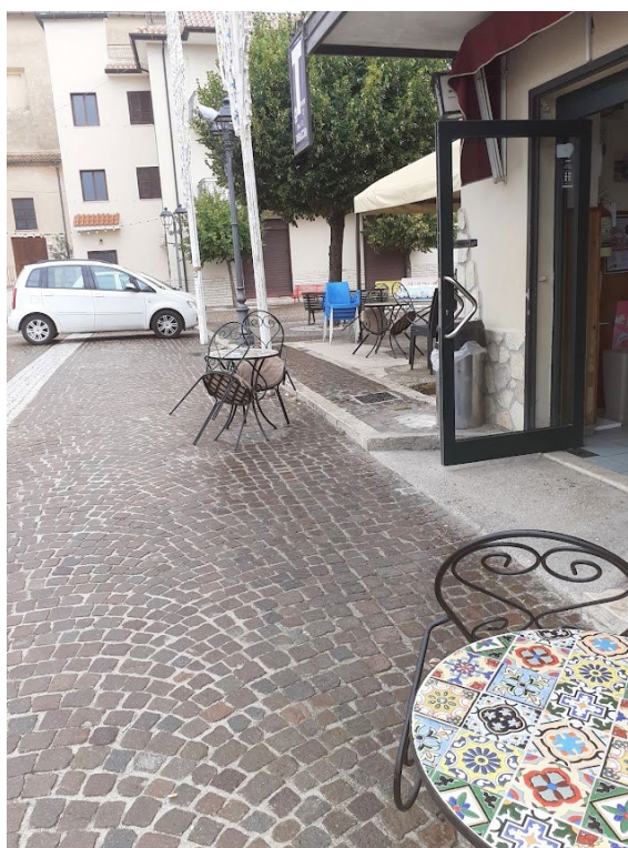
Fot. 6 Marciapiede privo di rampa inclinata.
