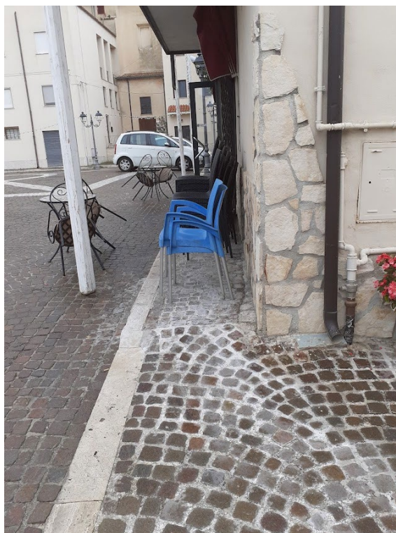
Fot. 5 Marciapiede occupato di dimensioni ridotto ed in raccordo con passo carrabile
