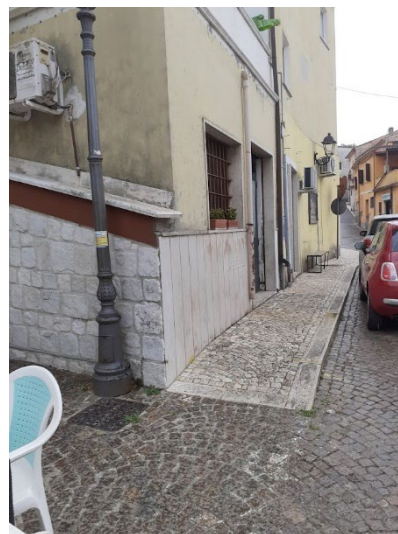
Fot. 4 Rampa lungo il marciapiede con sbarco su via Roma
