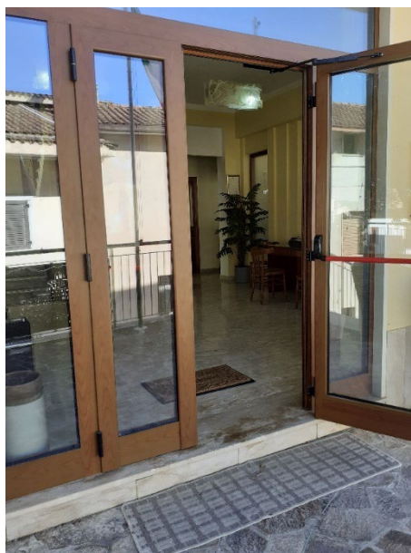
Fot. 5 Accesso al piano primo dalle rampe di scale
