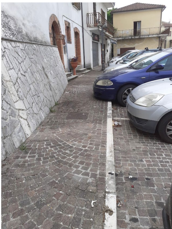
Fot. 4 Marciapiede con ingombro autovetture
