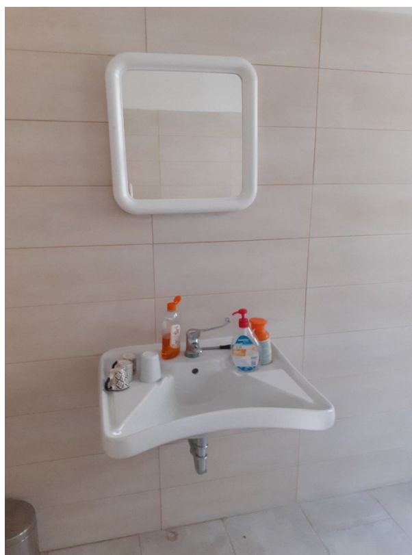
Fot. 10 Dettaglio servizi igienici
