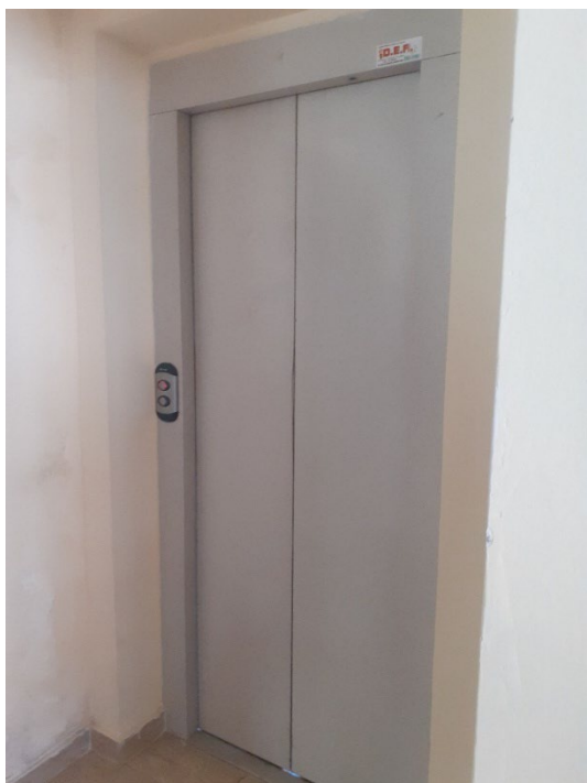
Fot. 7 Porta dell'ascensore al piano primo
