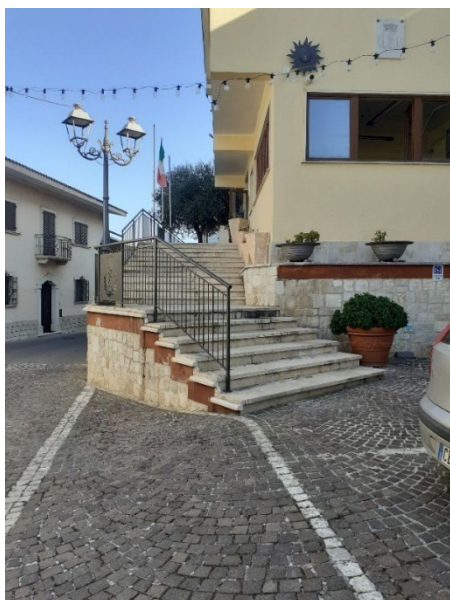
Fot. 1 Rampa di collegamento al piano primo
