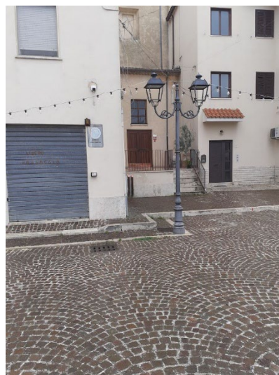
Fot. 2 Marciapiede senza rampa
